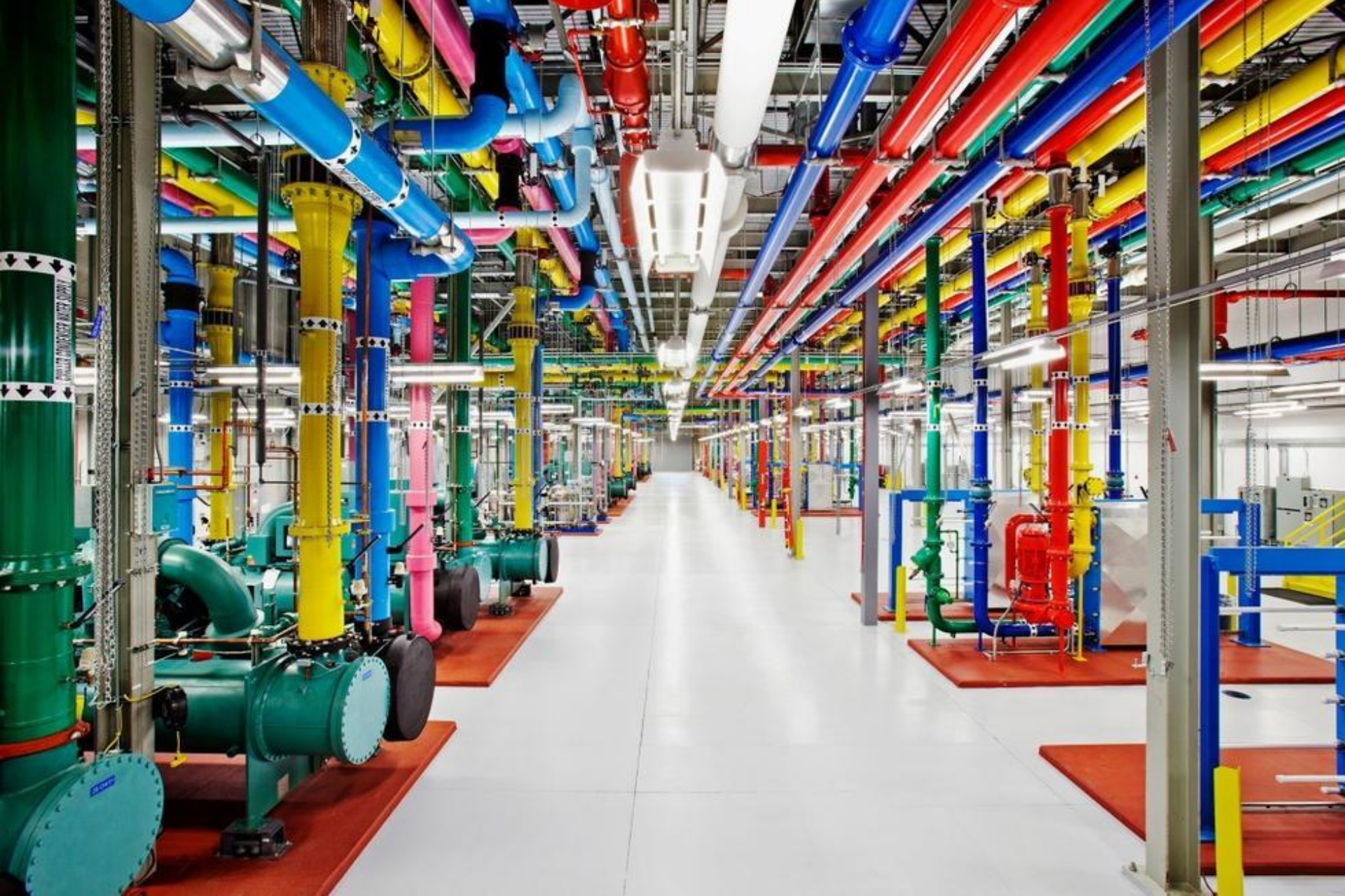
Google 数据中心的水循环冷却系统
